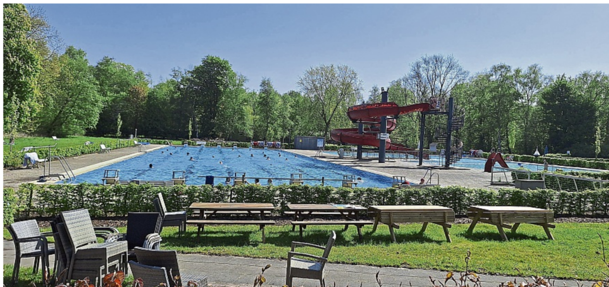
Die Stadt will den Schwimmpark Twistringens erhalten und setzt auf Sanierung. Doch diese wird erheblich teurer als bislang geplant. ARCHIVFOTO: SABINE NÖLKER
